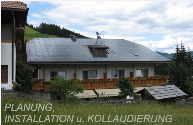
Photovoltaische Anlage 33,825 kWp mit architektonisch integrierten Modulen.
